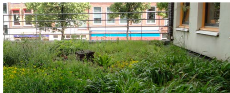
Schaduwnatuurdak op hoofdkantoor Stadsontwikkeling Zuiderdiep in Groningen.
